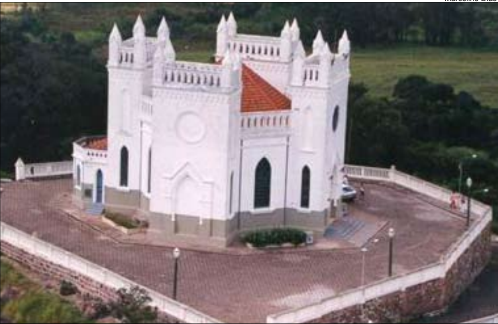
Plano prevê a construção de largas avenidas ligando a Rodovia Domingos Sartor
