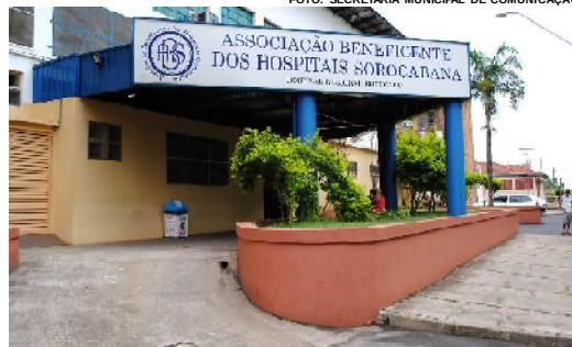
Fachada do Hospital Sorocabana, localizado na Vila dos Lavradores
