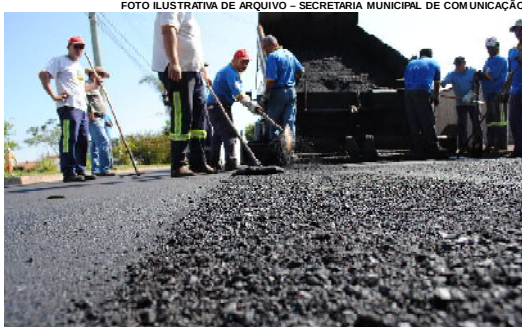
Convênio prevê mais de 25 mil metros quadrados de pavimentação
