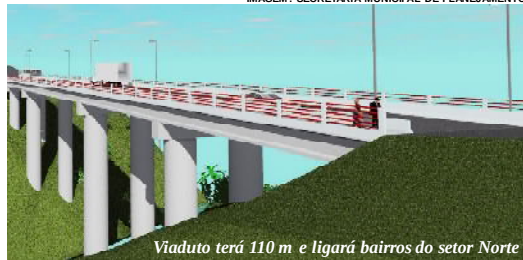
Viaduto terá 110 m e ligará bairros do setor Norte
