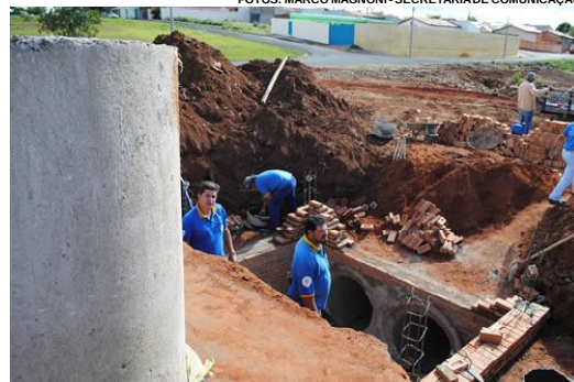
Área no Jardim Mirante recebe duas linhas de galerias pluviais
