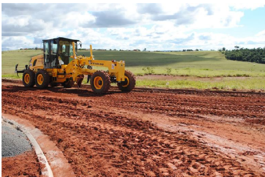
Rua Ângelo Antônio Papa é preparada para receber nova pavimentação
