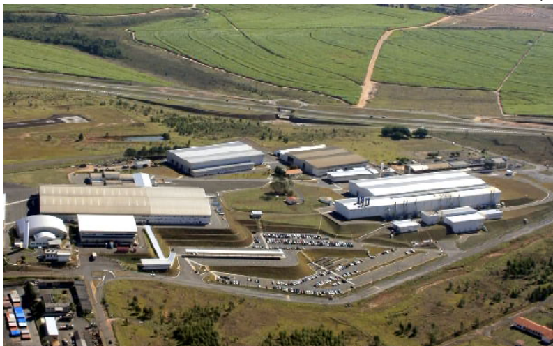
Nova via terá início no trevo de acesso ao Aeroporto Estadual, às margens da Castelhino
