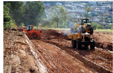
Máquinas em trabalho de limpeza e nivelamento na Estrada Municipal do Oyan, que receberá galeria, guias e asfalto novo
