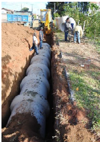
No local são instalados cerca de 200 metros de galerias
