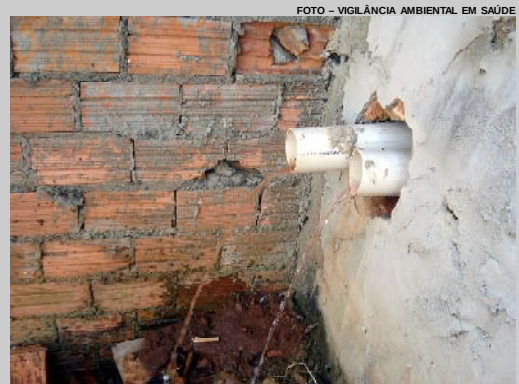
Destinação incorreta da água da chuva pode provocar entupimento de rede e retorno de esgoto
