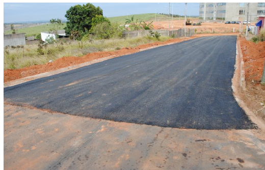
Cerca de 112 toneladas de massa foram utilizadas no serviço
