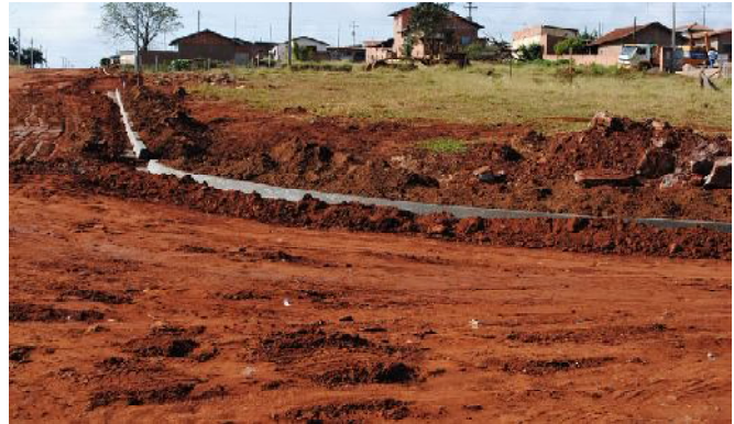
Via do bairro receberá 3.780 metros quadrados de pavimento novo
