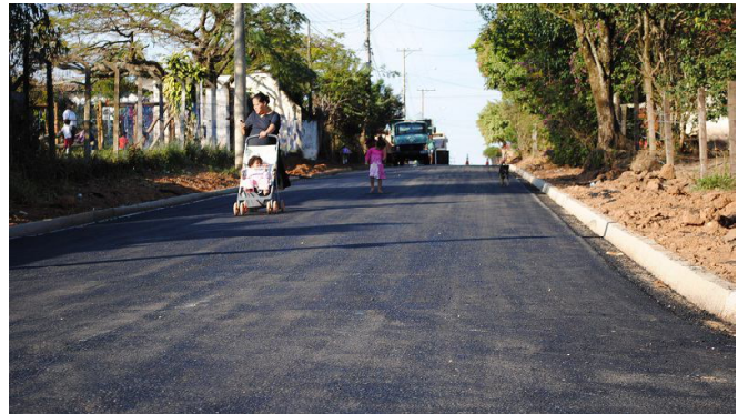
O investimento é de quase R$ 1 milhão para execução de 25 mil m² de pavimentação asfáltica
