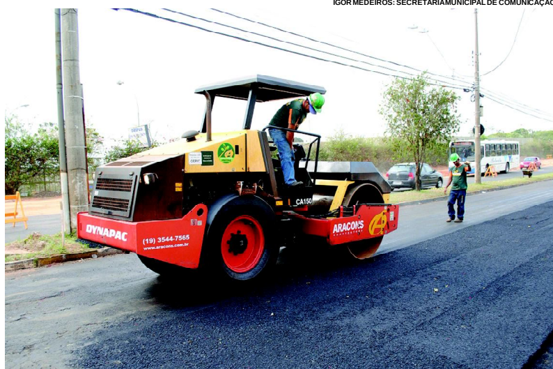
Fase de recape prepara avenida antes da construção de rotatória e ciclovia
