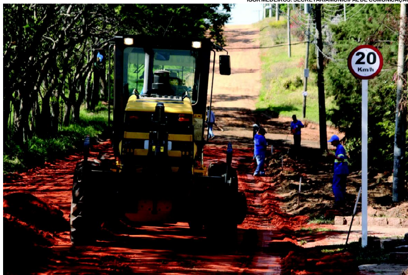
Máquina da Secretaria de Obras faz nivelamento na Rua Professor João Roberto Pilan
