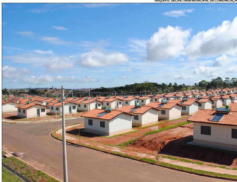
Residencial Santa Maria 1: construção de 407 casas foi primeira etapa do programa em Botucatu
