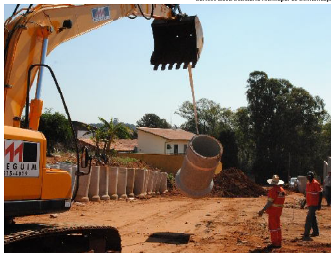
Máquinas colocam tubos de concreto que ampliará escoamento das águas das chuvas
