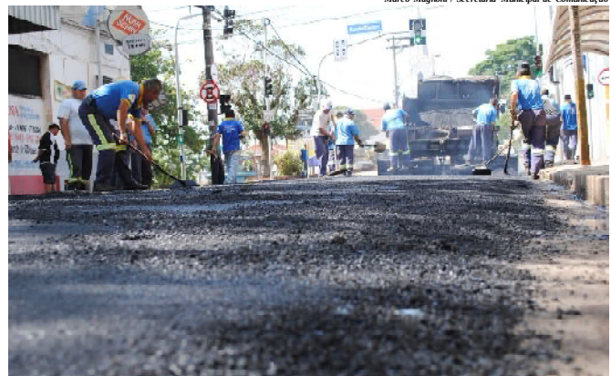
Secretaria de Obras utilizará um total de 1,6 mil toneladas de massa asfáltica
