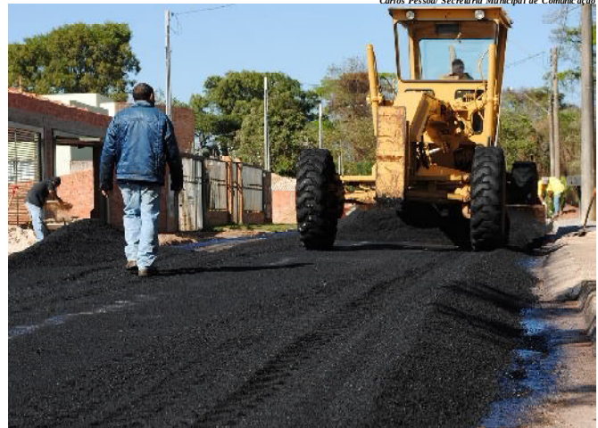
Serviço recupera mais de 47 mil metros quadrados de asfalto nos dois bairros
