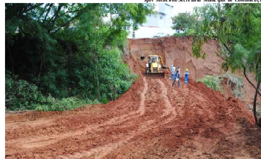
Máquinas trabalham na recuperação da área, que será reurbanizada
