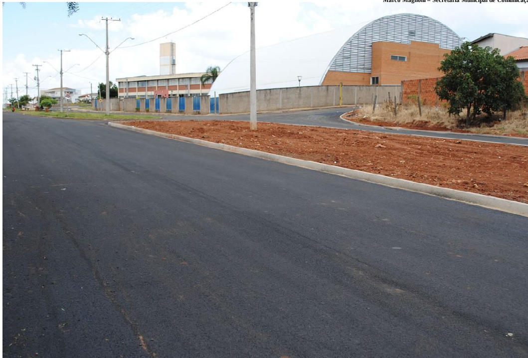
Obras na avenida, a principal do Jardim Eldorado, eram aguardadas há pelo menos oito anos
