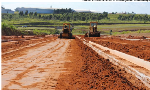
Pistas de nova avenida próxima à Castelinho terão quase 11m de largura
