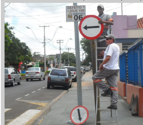
Na região central foram trocadas todas as placas de trânsito
