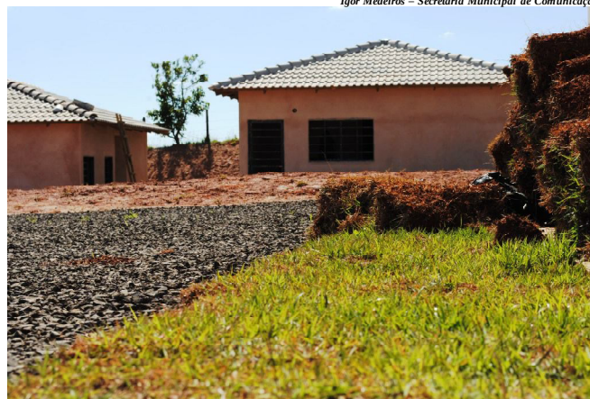
Casas do Flora Rica, construídas no bairro comerciais
