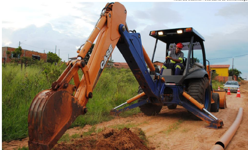
Obras no bairro Santo Antonio da Cascatinha devem transcorrer pelos próximos cinco meses
