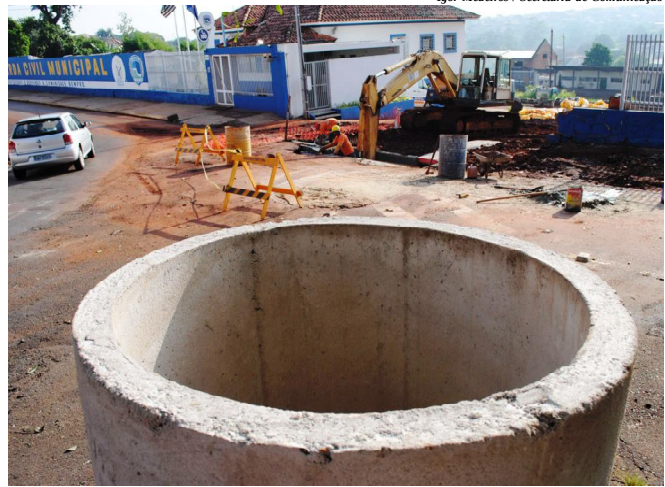
Galeria em frente à GCM poderá suportar volume de 15 metros cúbicos de água por segundo
