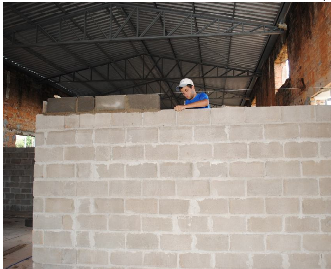
Local, hoje em obra, abrigará eventos e diversas atividades voltadas aos jovens
