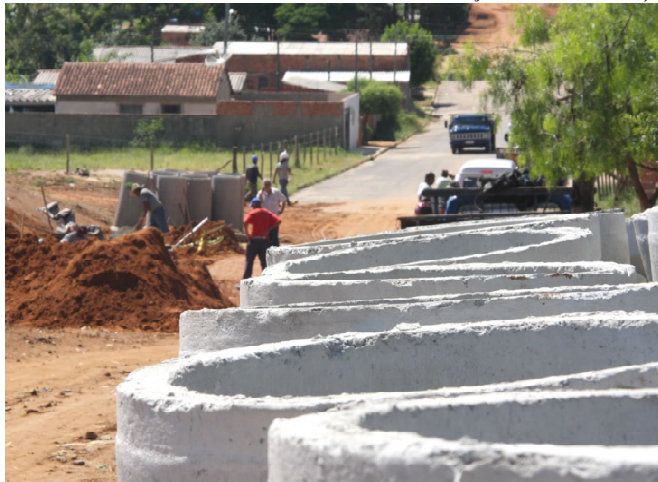
Avenida Rubens Rúbio da Rosa, no Santa Elisa, recebe galerias de águas pluviais
