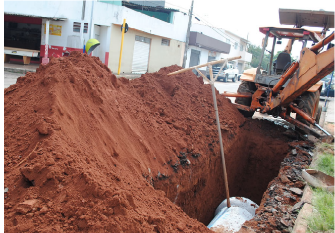
São mais de 250 metros lineares de tubulação para captação de água na entrada da Cohab 1
