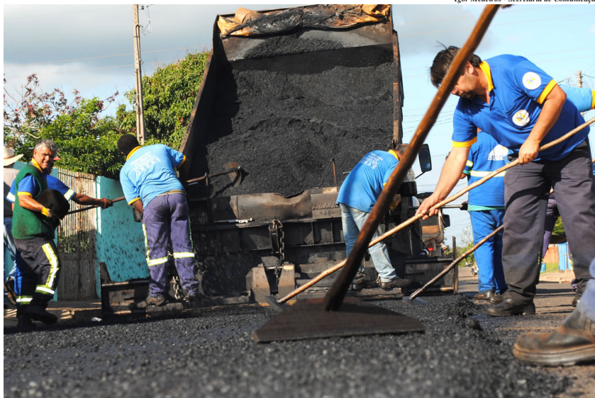
Equipe trabalha na recuperação de mais de 16 mil metros quadrados de asfalto
