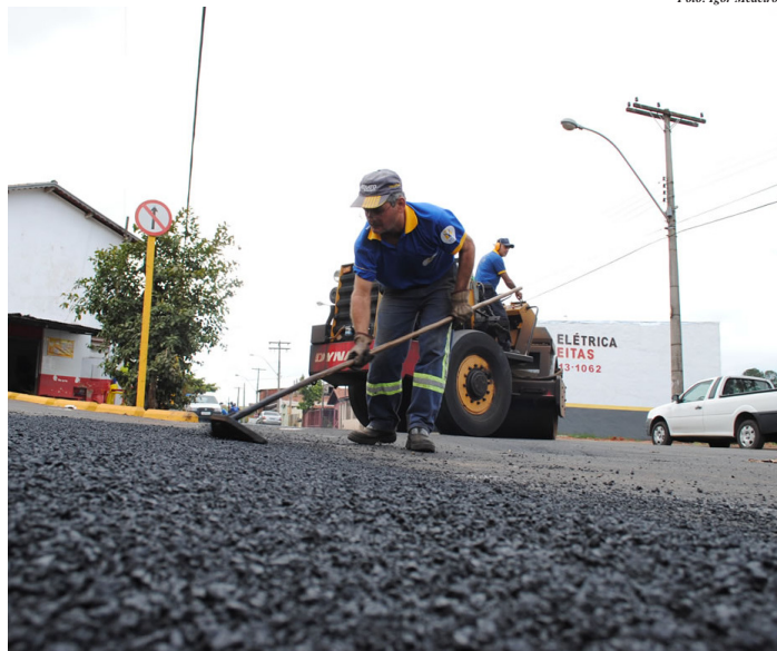
Foram utilizadas cerca de 300 toneladas de massa asfáltica no local
