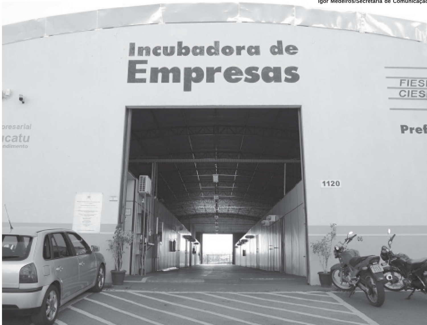
Prédio da incubadora recebeu melhorias, principalmente no telhado e parte elétrica
