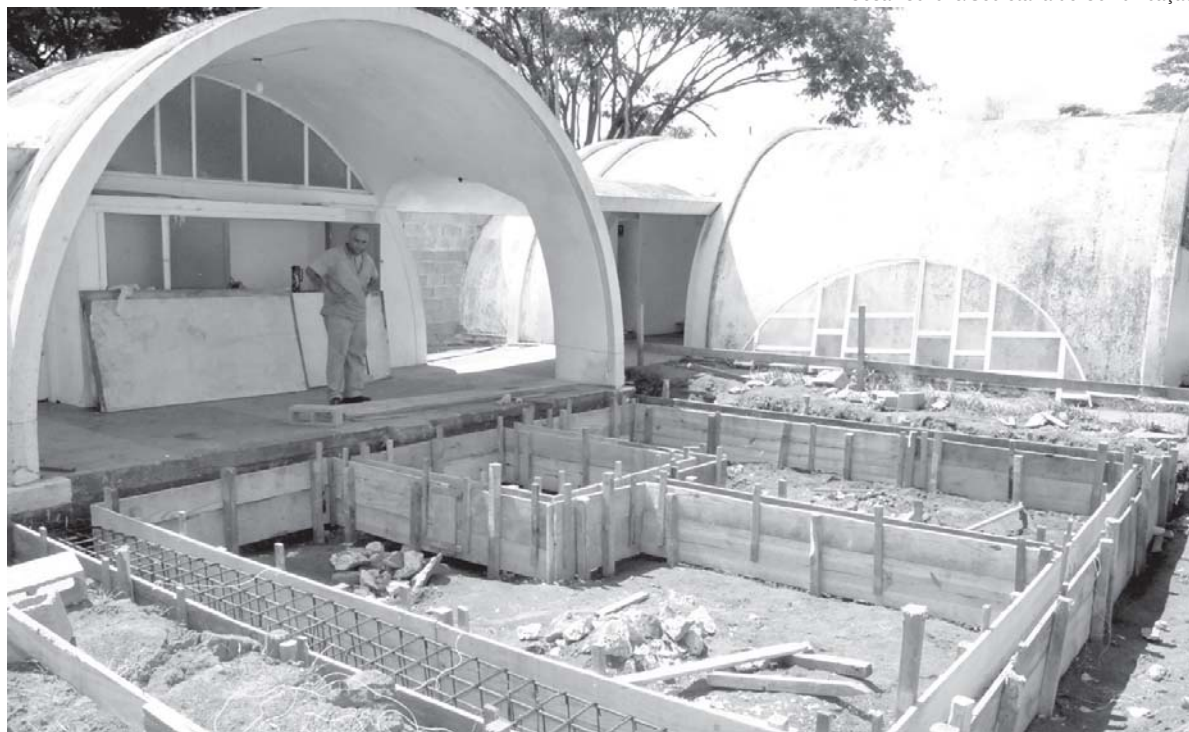
Construído em 1967, conjunto de prédios é ampliado para abrigar museus, biblioteca, oficinas e novos projetos
