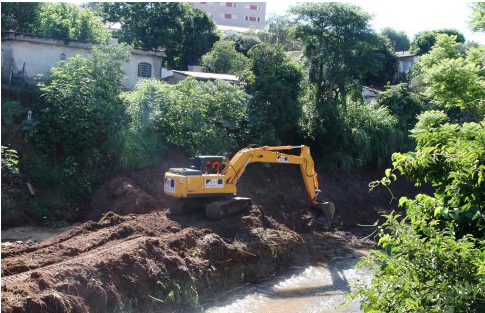
Máquinas trabalham desde dezembro passado nos trechos mais críticos do rio
