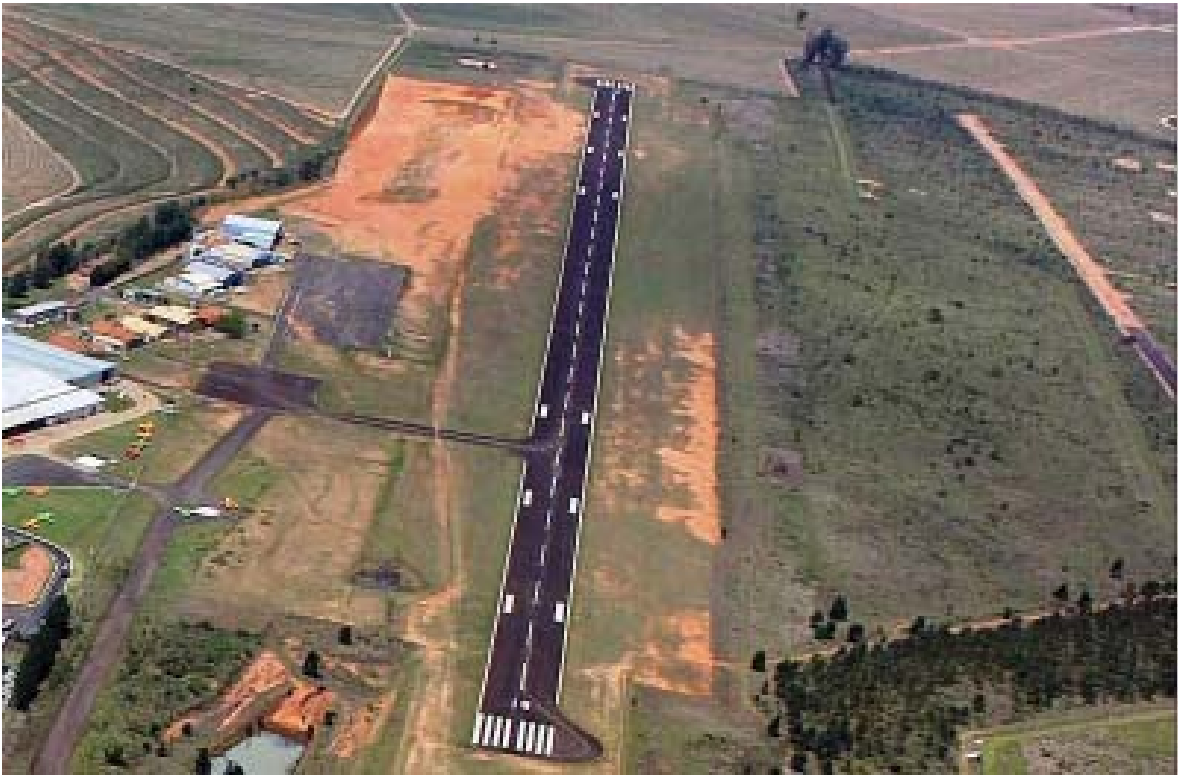
Pista do Aeroporto Tancredo Neves, com mais de 1,5 mil metros de extensão
