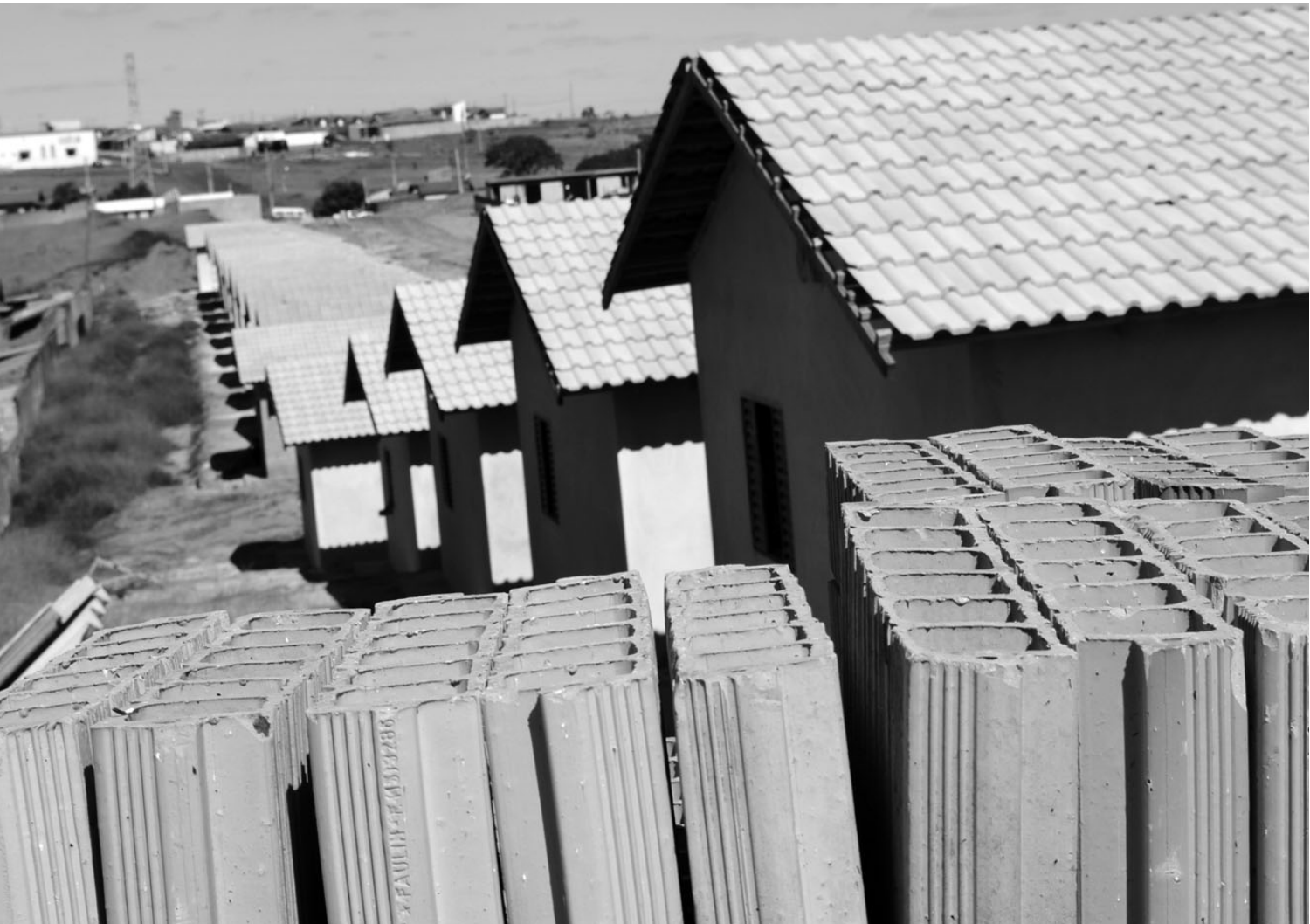
Em Botucatu, nos últimos quatro anos, foram construídas mais de 1,4 mil moradias
