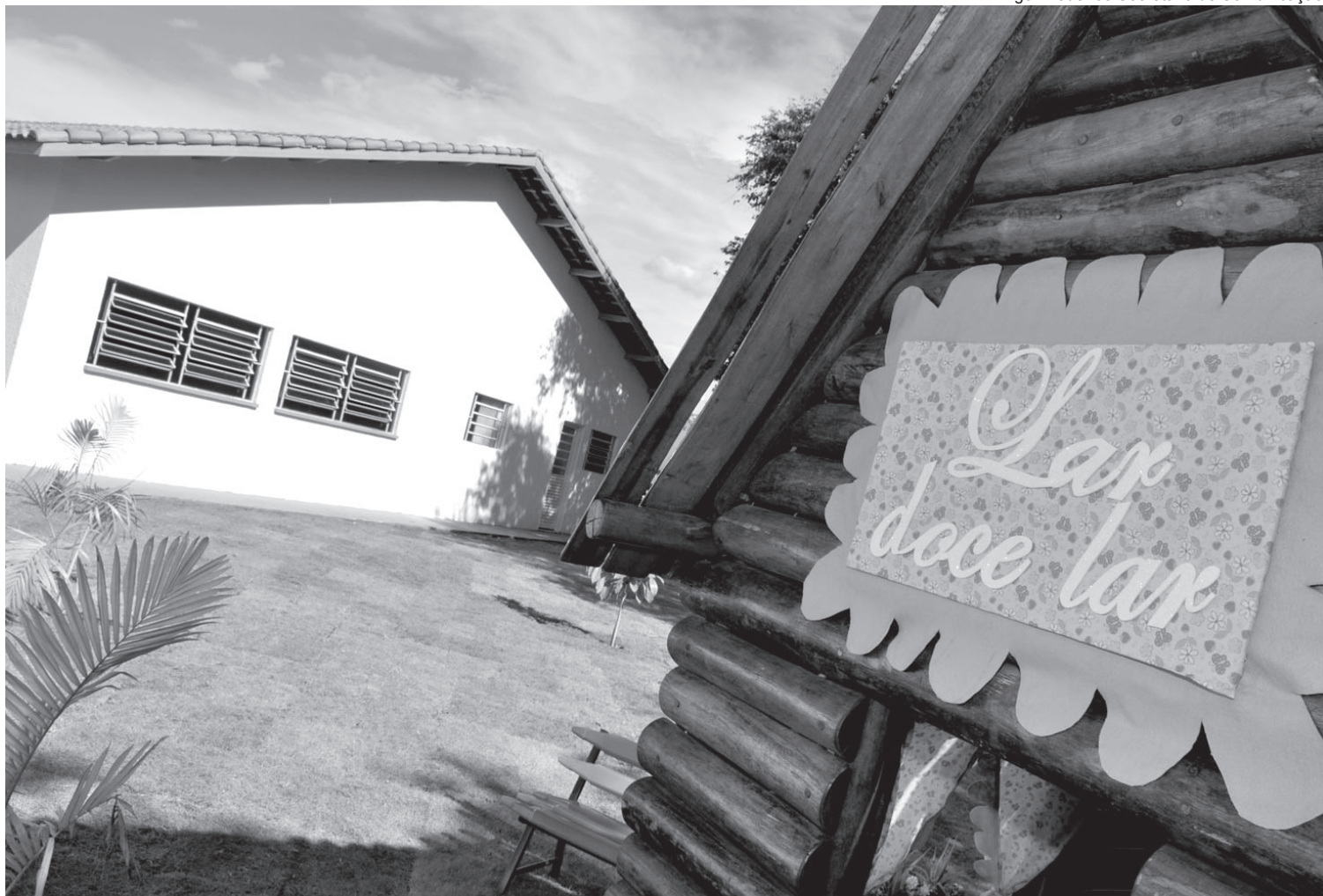
Creche tem salas, telhado e pintura novas; obra é demanda do Orçamento Participativo desde 2006
