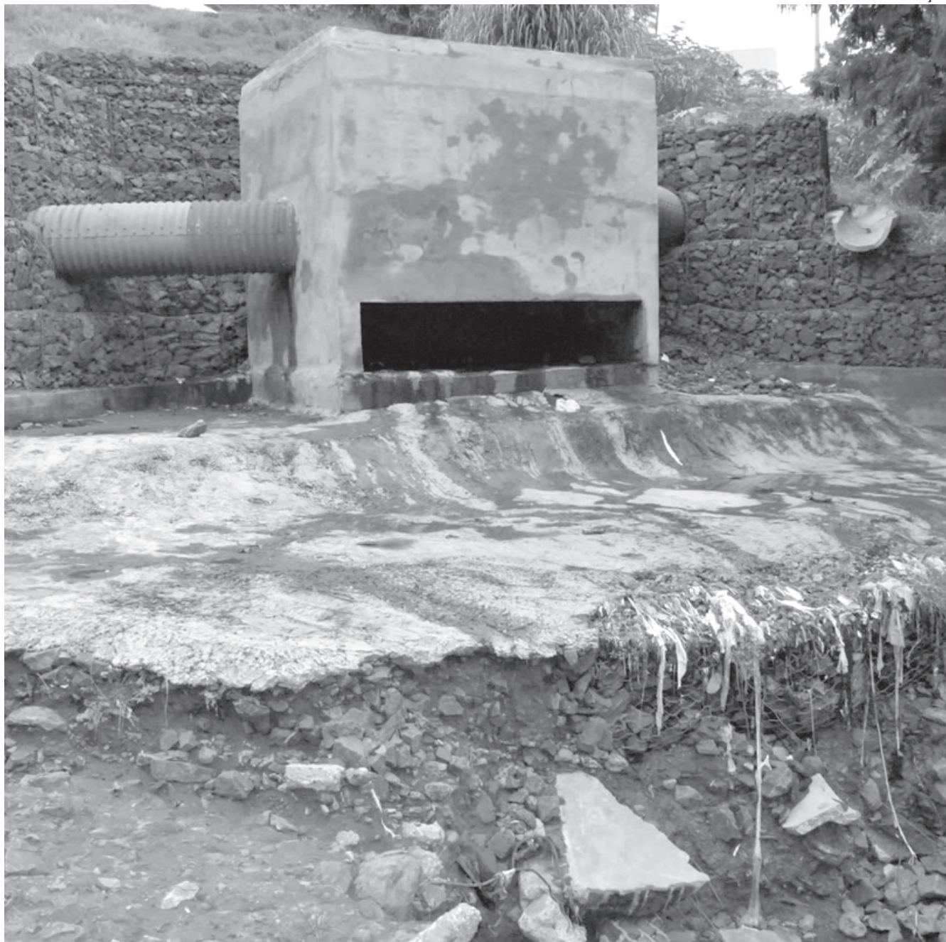
Sistema de dissipação da água das chuvas construído em área ao lado da Salim Kahil
