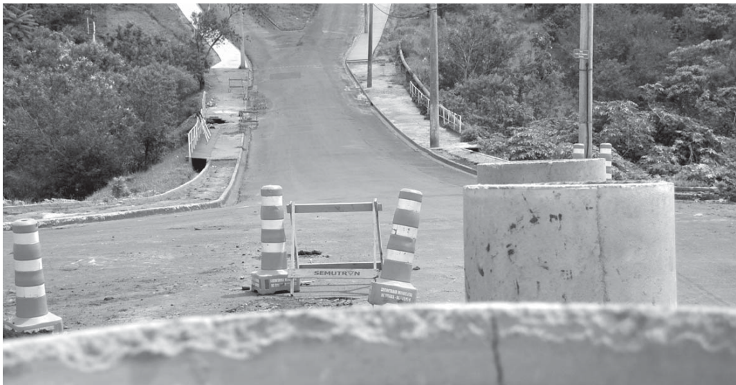
Obras buscam corrigir estragos feitos pela chuva na entrada do bairro
