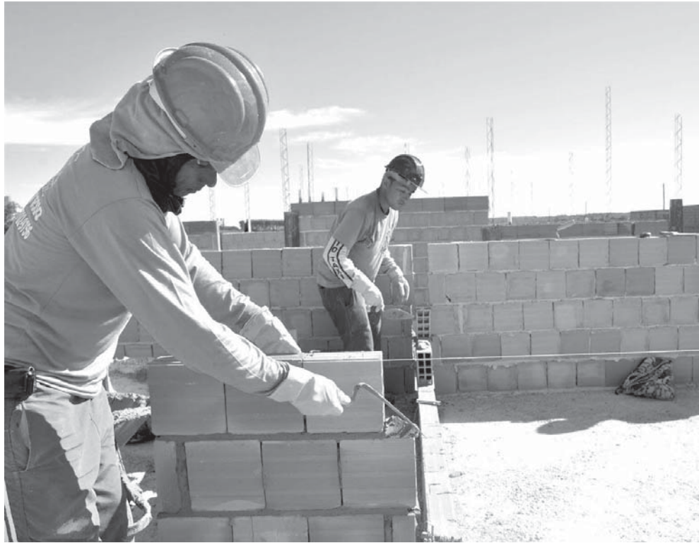
Construção das 499 casas está em ritmo acelerado em Rubião Júnior
