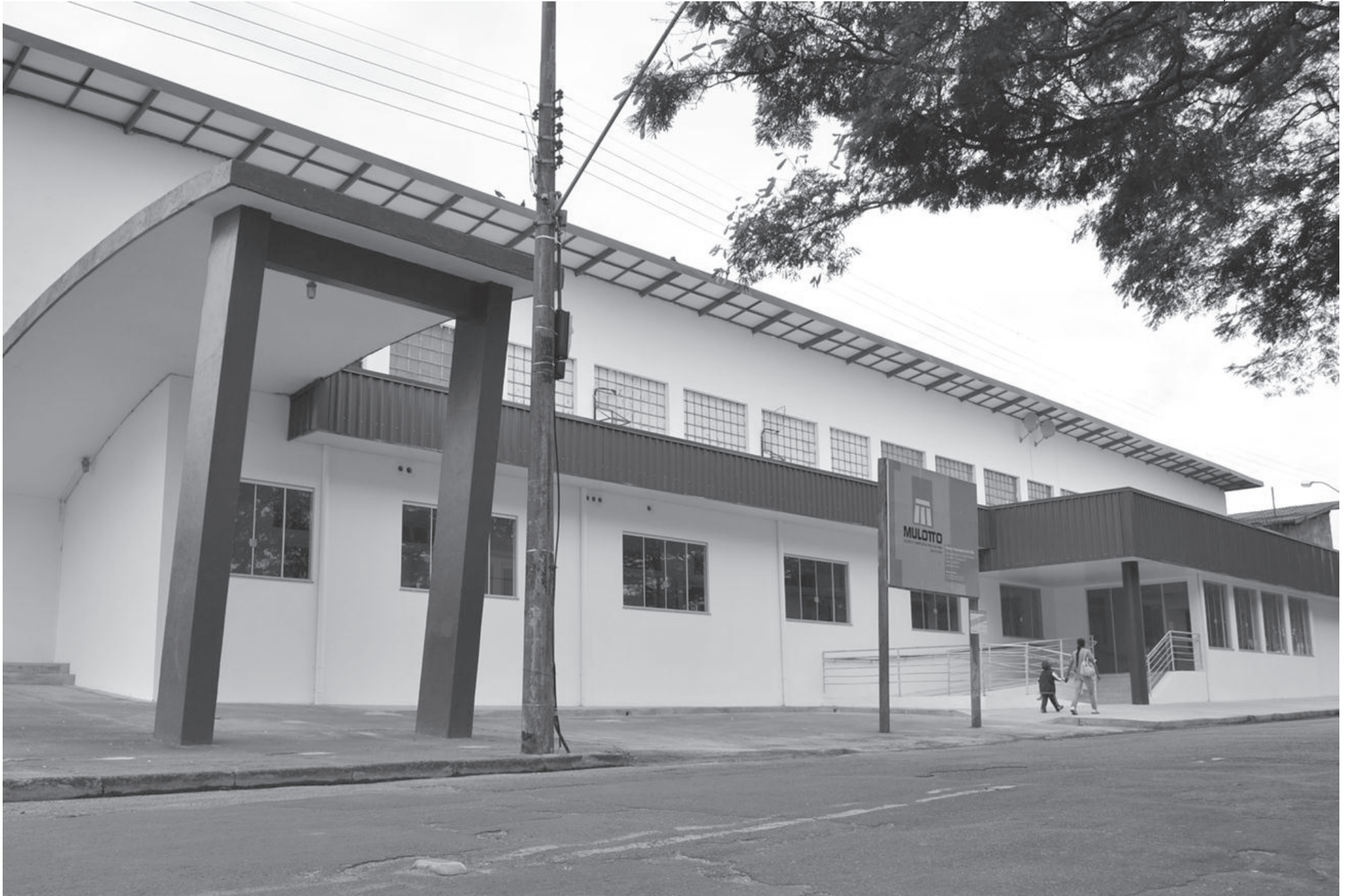
Prédio do antigo Hospital Sorocabana foi adquirido pelo Município e recebeu ampla reforma; atendimento inicia dia 17 deste mês.
