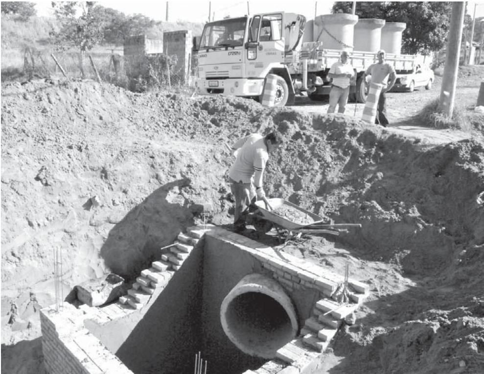
No total, rua será contemplada com 500 metros lineares de tubulações
