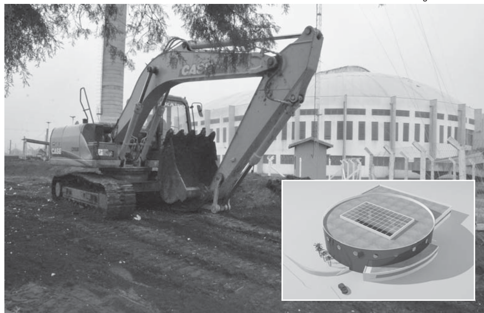
Construção dos Centros de Inclusão fica em área anexa ao Ginásio Municipal
