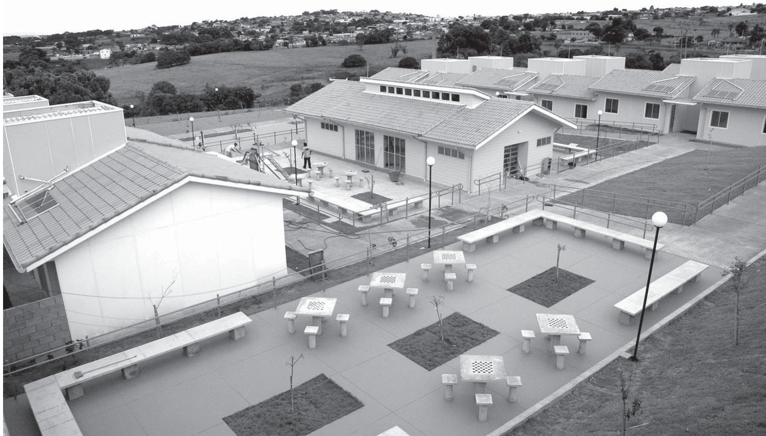
Conjunto habitacional terá 16 unidades na Cohab 1, com destaque à acessibilidade e paisagismo; na foto, Vila Dignidade de Itapeva
