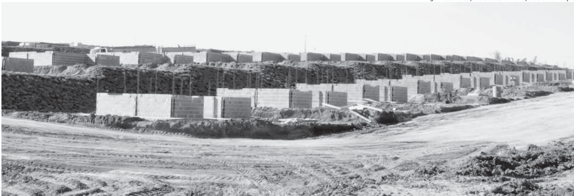
Jardim do Bosque I está com 330 casas em construção, próximo ao Maria Luíza
