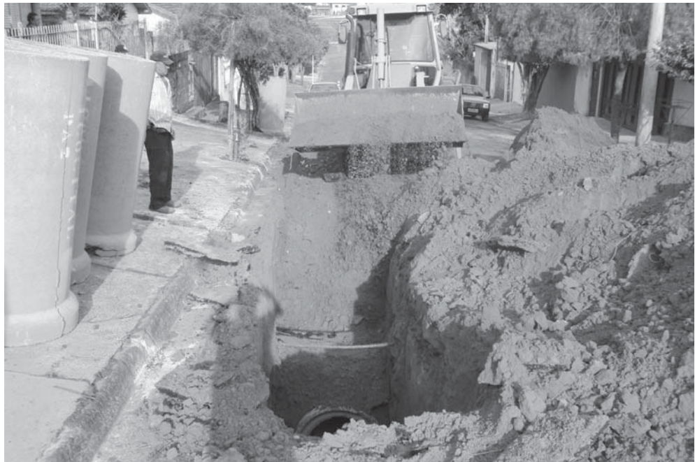
Avenida Dom Pedro I ganhará maior vazão para a água das chuvas
