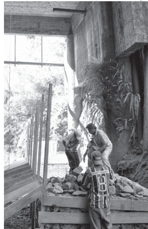
Muro de gabião terá cinco metros de altura junto à ponte
