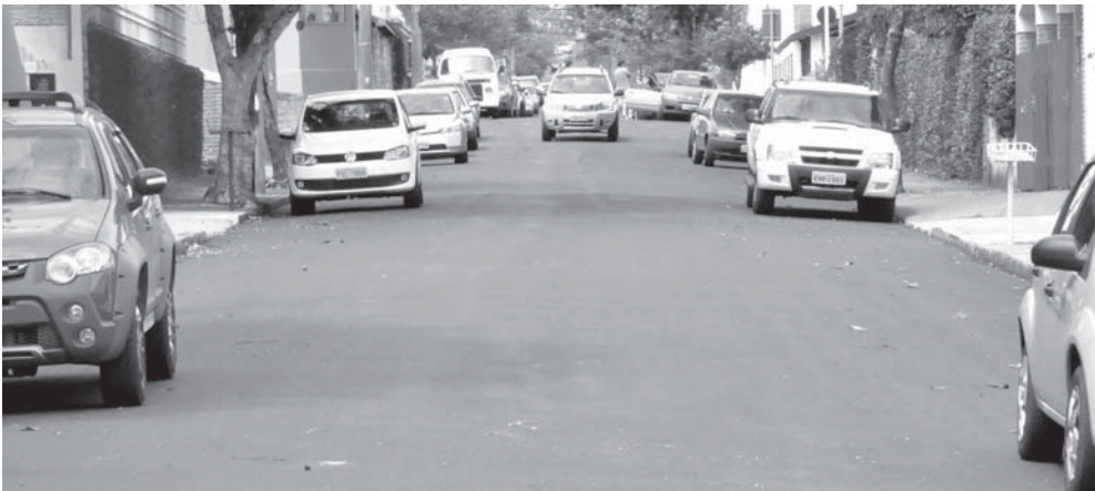
Recape de aproximadamente 800 metros melhora trafegabilidade dos veículos
