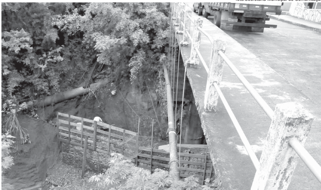
Muro de gabião dará maior suporte na estrutura da ponte
