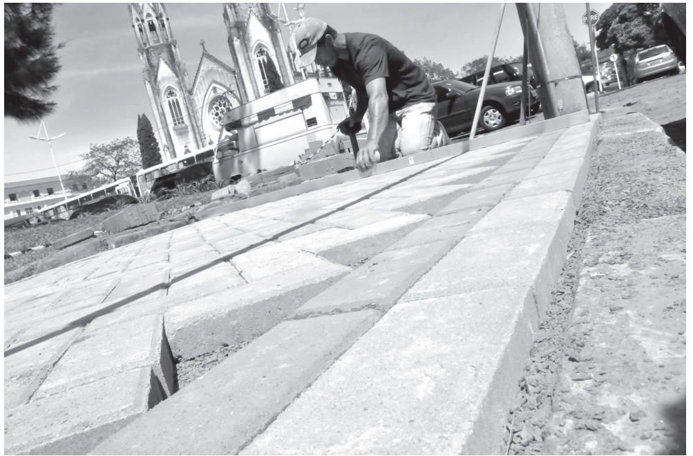
Calçadas têm novo tipo de piso e seguirão padrões de acessibilidade
