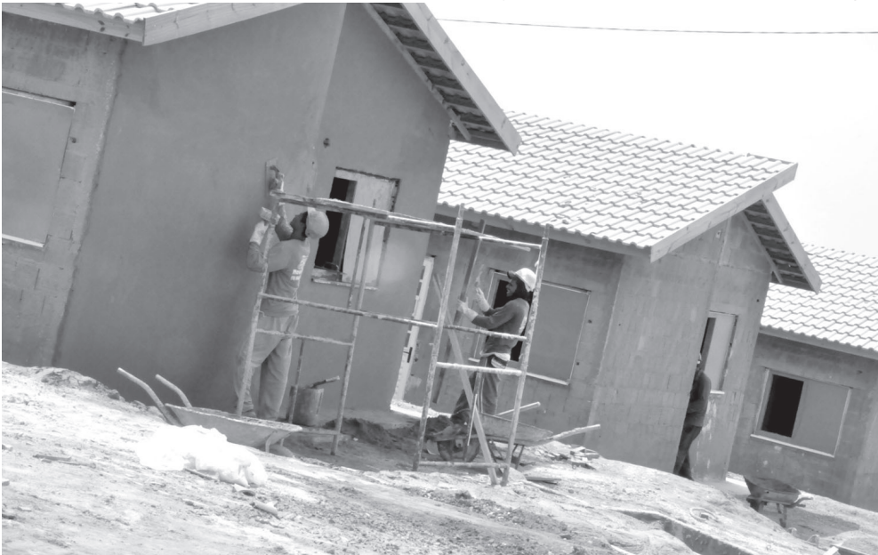
Obras no Jardim do Bosque I estão avançadas
