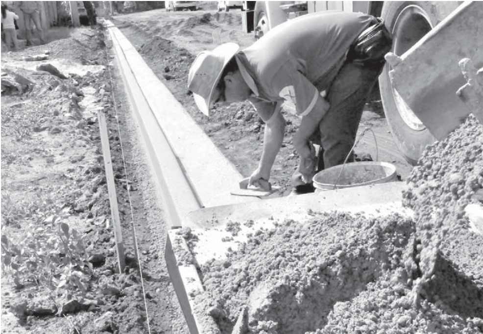
Ruas do Jardim Vitória II ganham guias e sarjetas para posterior pavimentação
