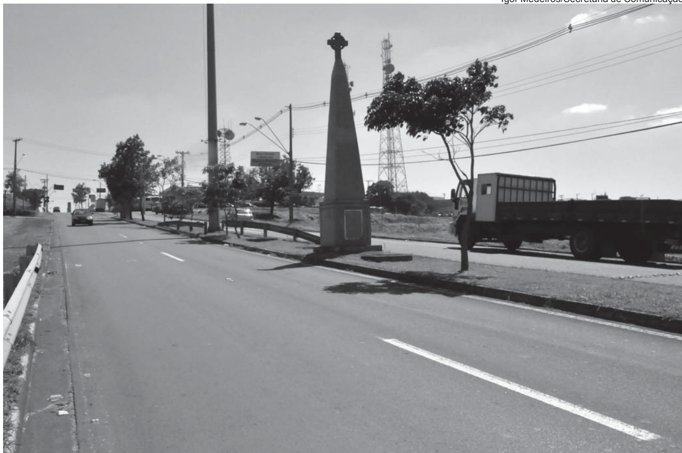
Um dos recursos é para construção de pórtico na Avenida José Pedretti Neto, uma das entradas da Cidade
