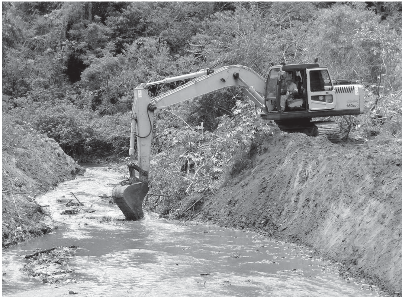
Máquinas da Secretaria de Obras em trabalho no córrego Água Fria
