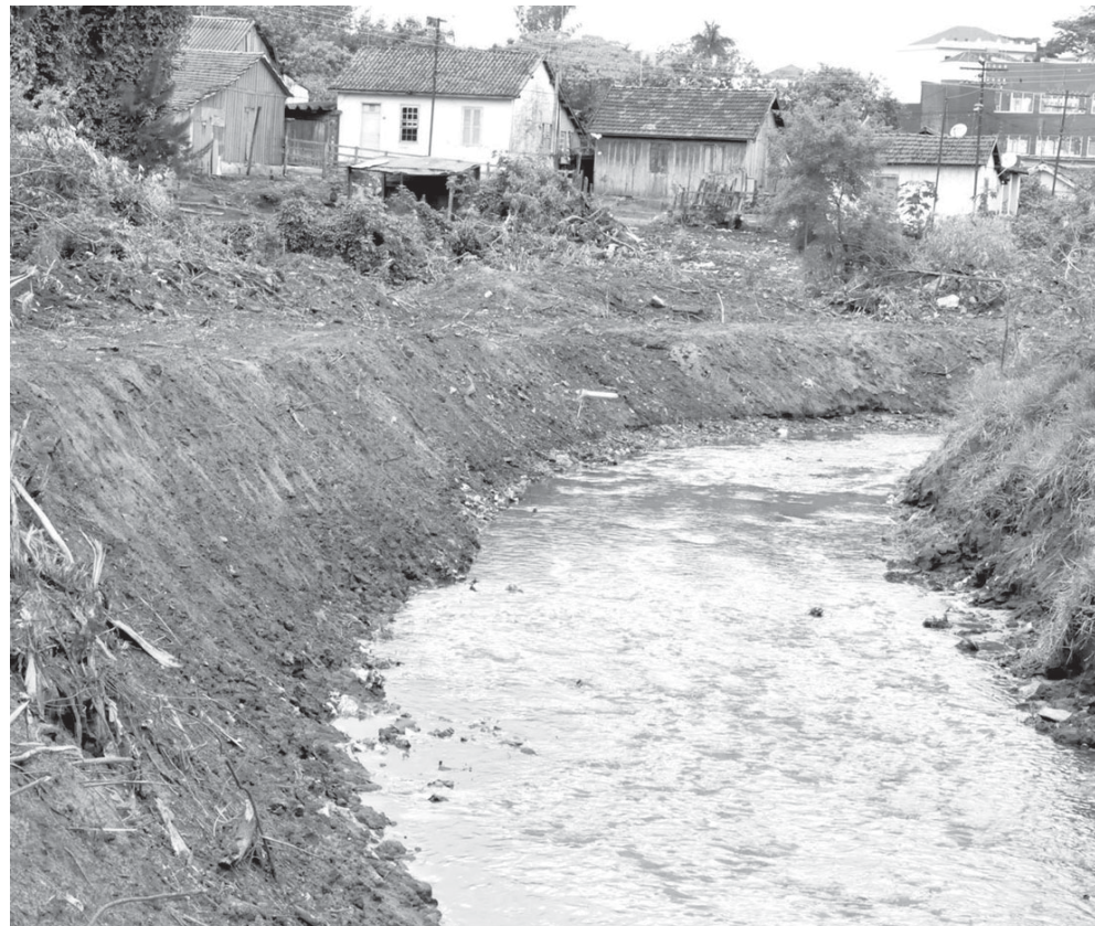
Entre os diversos serviços realizados foi feito o alargamento e limpeza do Córrego Água Fria
