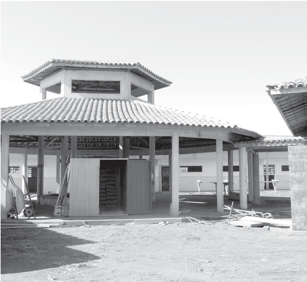
Unidade atenderá 360 alunos; obras devem ser concluídas em 120 dias
