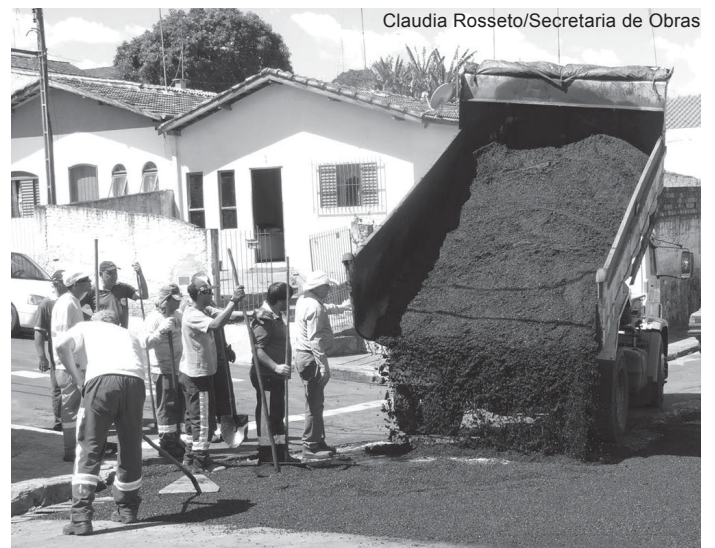
Foram utilizadas cerca de 10 toneladas de massa asfáltica no local
