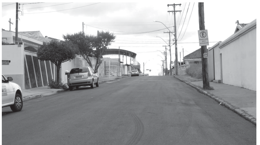
Rua Virgílio Bartoli com o asfalto recuperado pela Secretaria de Obras
