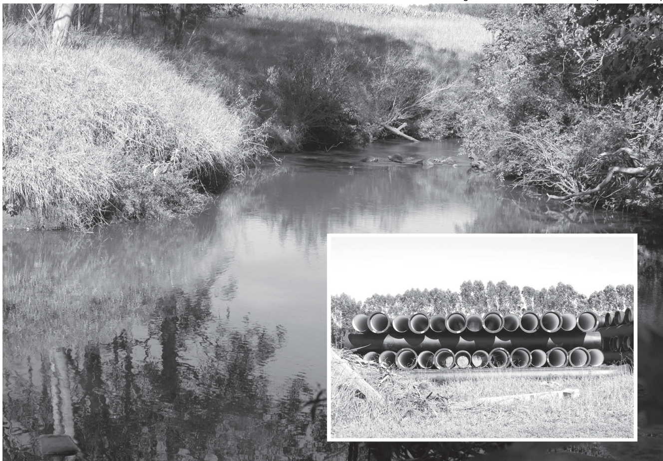
Estiagem tem prejudicado volume do Rio Pardo; obra prevê 8.300 metros de adutora
