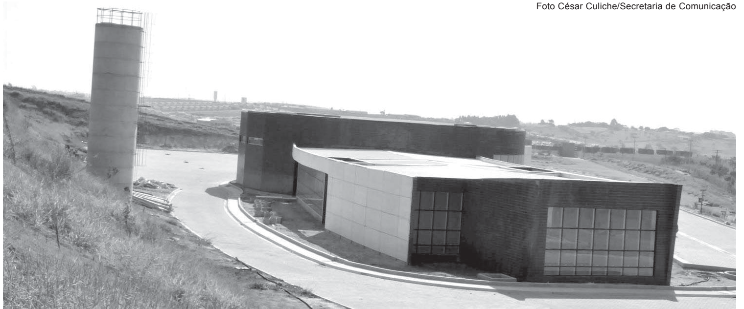
Obras do ParqueTec Botucatu, às margens da Gastão Dal Farra, estão adiantadas
